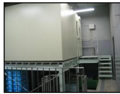
恒温恒湿室外観
